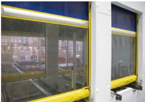
Le système d'entrée protège la chambre des différences de température et de pression causées par le passage continu des unités de charge.
